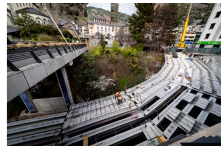
▲ S'unifica la base de l'estructura on es va col·locar el quitrà. L'estructura està formada per uns ferros, els quals permeten que hi hagi sempre seguretat.
