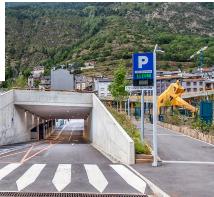
▲ S'ha construït un nou aparcament amb 80 places cobertes, i s'ha soterrat el carrer de la Molina, millorant la circulació general de la vila i la seguretat dels vianants. El nou equipament és accessible des de diferents punts: des de l'avinguda Príncep Benlloch, des del carrer de la Molina, des del carrer del Prat Gran de l'Areny i des de la passarel·la de la Mola.
