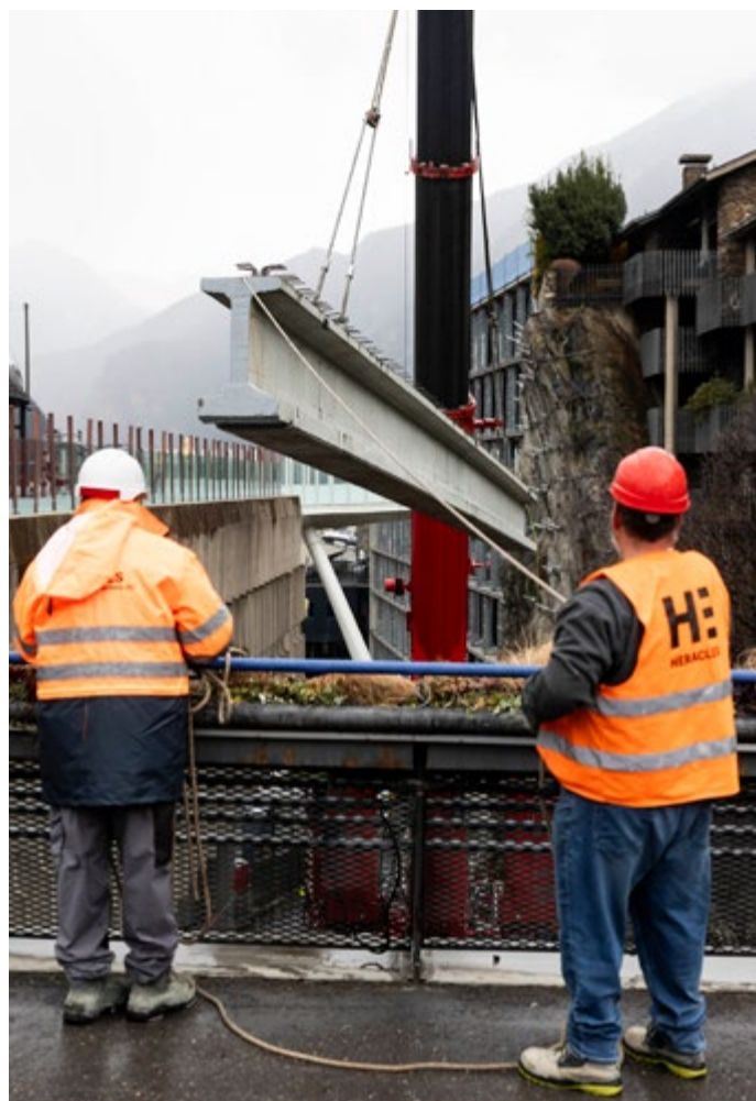
▲ Es pot observar com s'estaven col·locant les bigues que serveixen com a repòs per als pilars que aguanten tota l'estructura.
