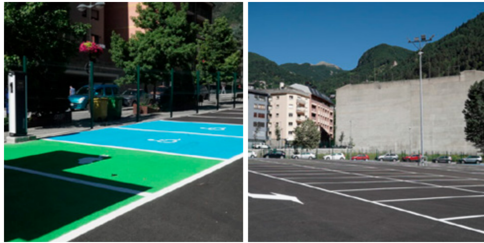
▲ El nou espai d'aparcament ofereix punts de recàrrega per a vehicles elèctrics.
