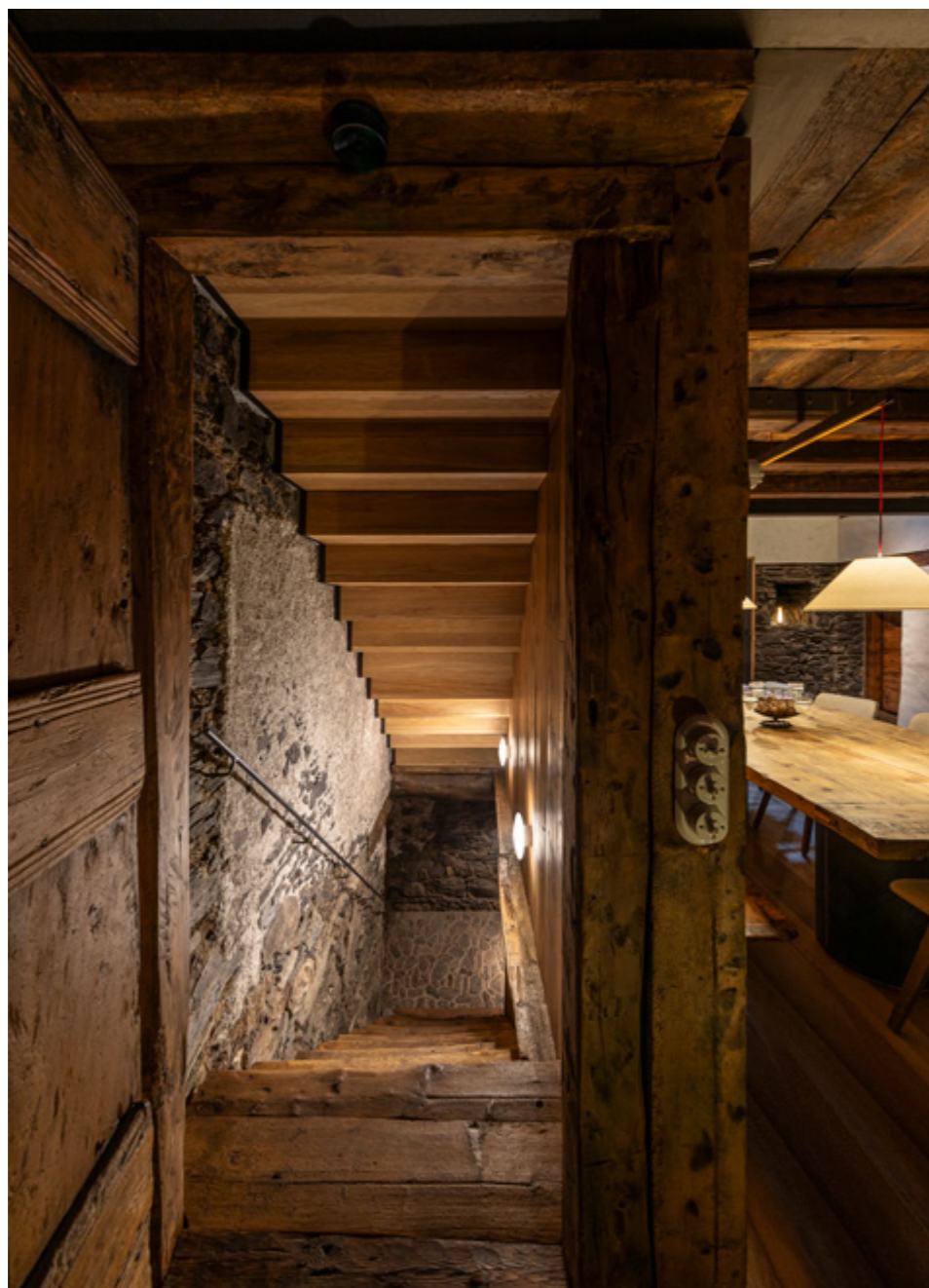
▲ S'han preservat les textures i sensacions de la casa primigènica, deixant els panys de pedra i els arrebossats amb morter de calç.
