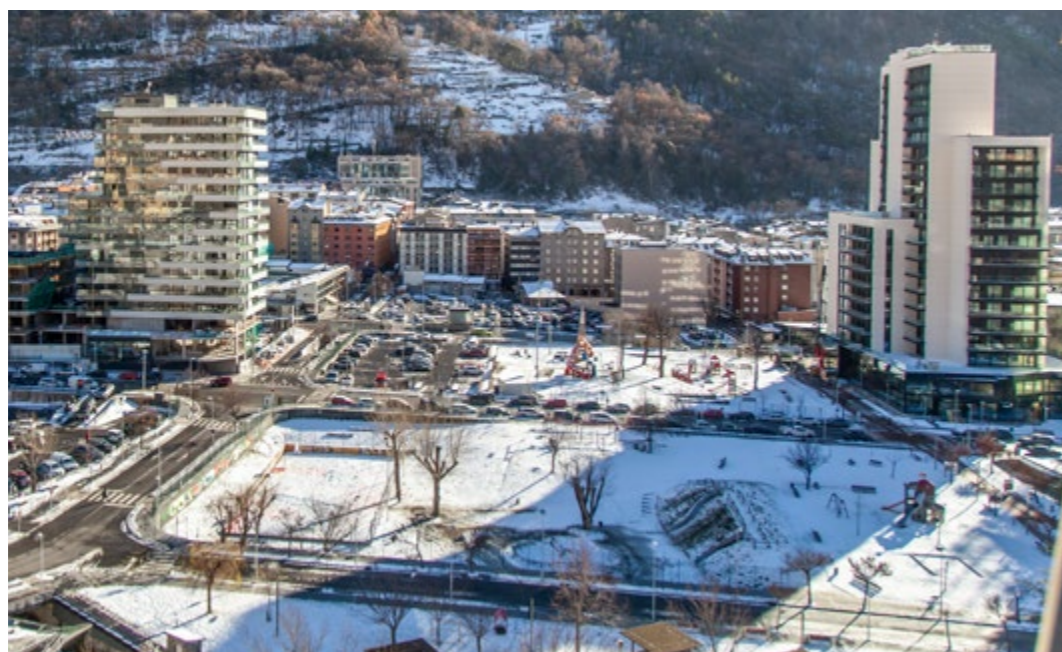
A la zona del Clot d'Emprivat es preveu la construcció de 10 torres més - Foto: ADV
