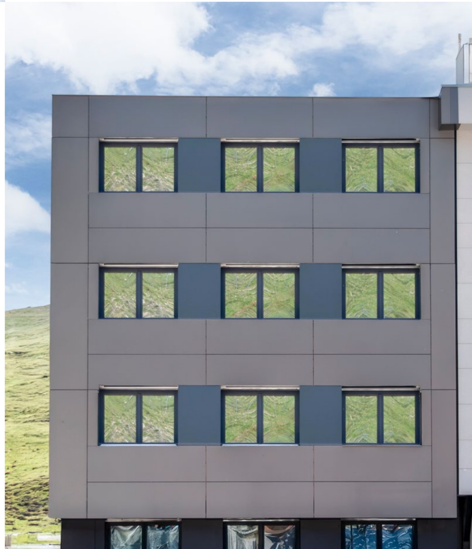
▲ La façana posterior, situada a la plaça Coprínceps del Pas de la Casa
